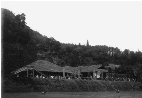
明治39年に現在の場所に新築移転した校舎
